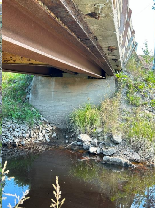
Figur 11. Bilde tatt fra vestsiden mot øst. Lite vegetasjon og bratt fyllingskjegle. Ugunstige forhold for passeringer for småvilt. Vannstanden var veldig lav ved befaringstidspunktet.
