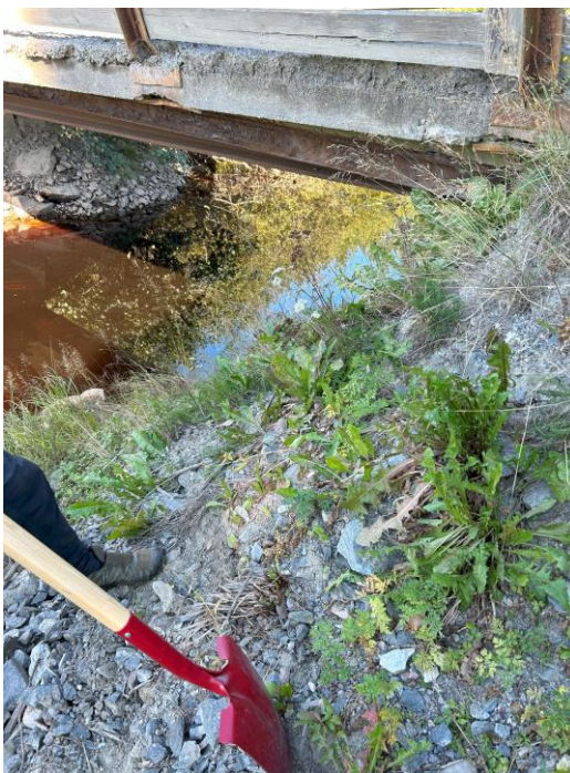
Figur 10. Bilde fra erosjonssikringa tatt ned mot elva. Det var lite vegetasjon på den østre siden av brua, og under brudekket synes så vidt deler av erosjonssikra på andre siden også. Kilde: Sweco
